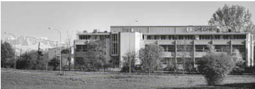
Der neue Produktionsstandort von DYCONEX in Bassersdorf bei Zürich
